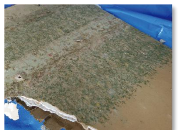
Nấm mốc sinh sôi ở mặt sau tường là tấm thạch cao hoặc gỗ dán nhiều lớp
