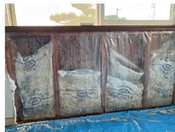
Tình trạng để nguyên vật liệu cách nhiệt bị ướt ở mặt sau tường
